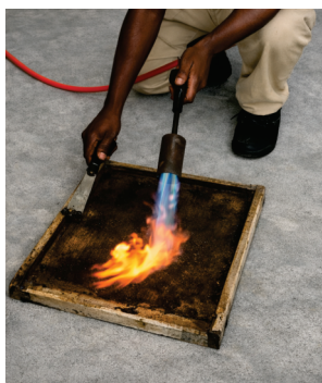
Entretien des planchers (Grattage et traitement à la flamme)
